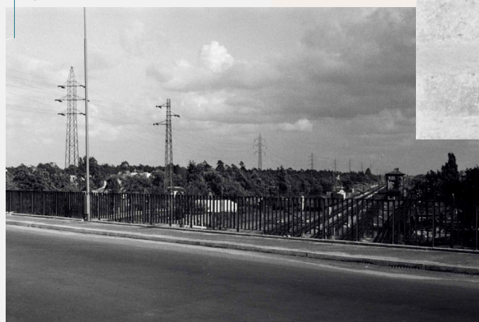
Widok na stację kolejową PKP Warszawa Wawer z nowo oddanego wiaduktu łączącego ulicę Płowiecką i Bronisława Czecha. Wcześniej był tu przejazd kolejowy, obsługiwany przez droźnika, uciążliwy dla pojazdów ze względu na częste zamykanie spowodowane charakterem towarowym stacji w Wawrze. Wawer, 1963 r. Negatyw czarno-biały, 35 mm.
